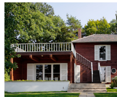
Abb. 1.1 Dachterrasse des Einsteinhauses in Caputh
